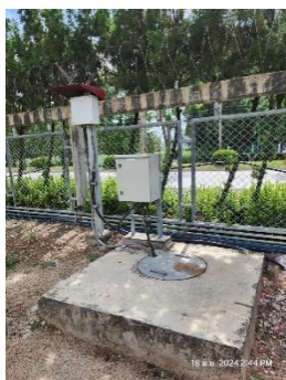
ภาพที่ 2-6 บ่อตรวจสอบคุณภาพน้ำทิ้ง (Inspection Manhole)
