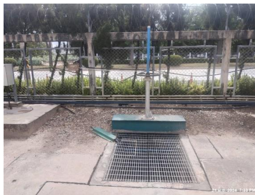
ภาพที่ 2-9 ประตูละบายน้ำของรางระบายน้ำฝน
