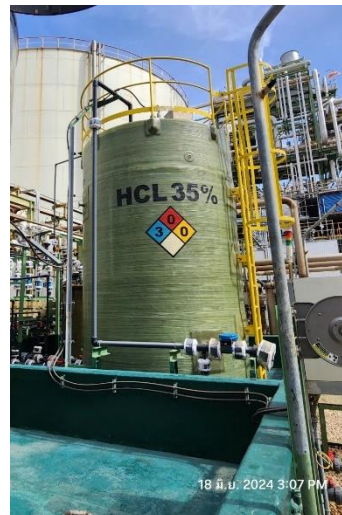
ภาพที่ 2-28 ถังเก็บสารละลาย HCl
