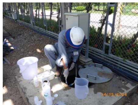
ภาพที่ 2-6 บ่อตรวจสอบคุณภาพน้ำทิ้ง (Inspection Manhole)
