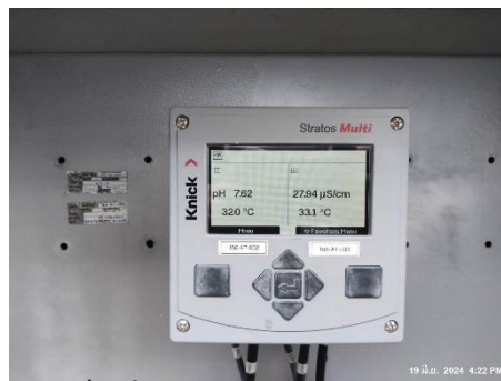
ภาพที่ 2-4 การติดตั้งเครื่องมือตรวจวัดคุณภาพน้ำอัตโนมัติ
