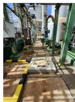
ภาพที่ 2-6 บ่อตรวจสอบคุณภาพน้ำทิ้ง (Inspection Manhole)
