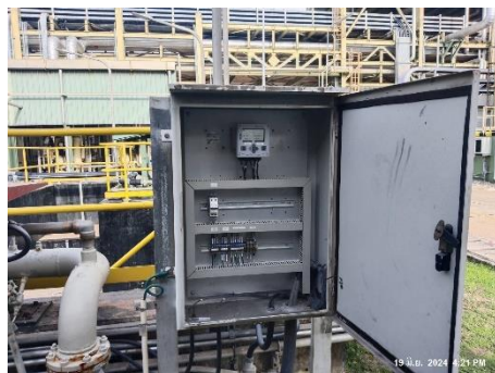
ภาพที่ 2-4 การติดตั้งเครื่องมือตรวจวัดคุณภาพน้ำอัตโนมัติ
