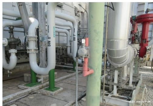
ภาพที่ 2-31 Gas Detector และ Ammonia Detector
